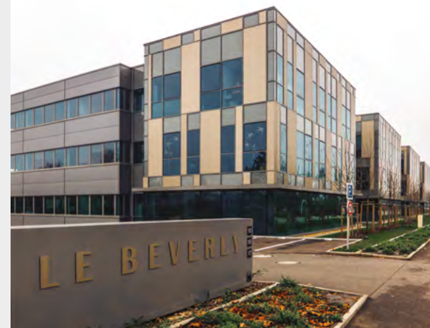
LE BEVERLY • STRASBOURG SCHILTIGHEIM (67) SURFACE 7.054 M 2 DE BUREAUX
